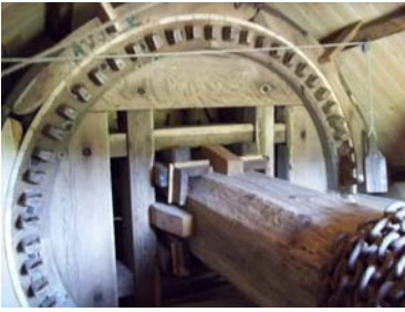
Dit jaar jaar werd de voering van het bovenwiel vervangen
